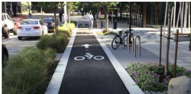
CALÇADA COM FAIXA DE SERVIÇO (CANTEIROS E PARACICLO), CICLOFAIXA ELEVADA E BIOVALETA RECEBENDO AS ÁGUAS DA VIA
