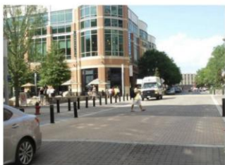
TRAVESSIA ELEVADA E REDUTOR DE VELOCIDADE
